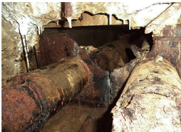
Рис. 7. Дефекты наружной коррозии на тепловых сетях [6]
