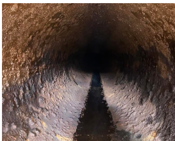
Рис. 8. Внутренняя коррозия на тепловых сетях [6]
