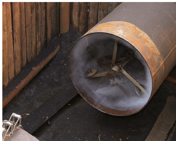
Гидродинамическая чистка трубы сверхвысоким давлением до 2500 атм
