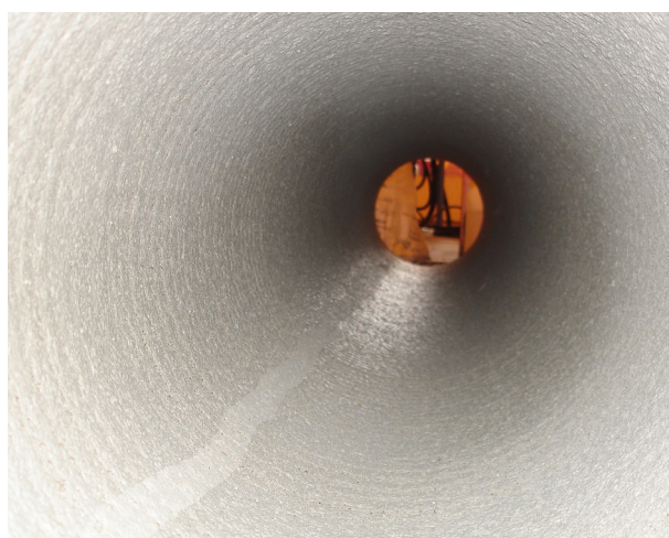
Внутренняя поверхность трубы после нанесения
