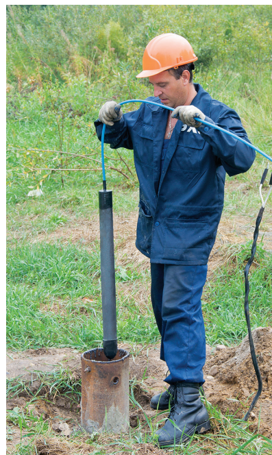
Рис. 4. Монтаж магнетитовых АЗ
