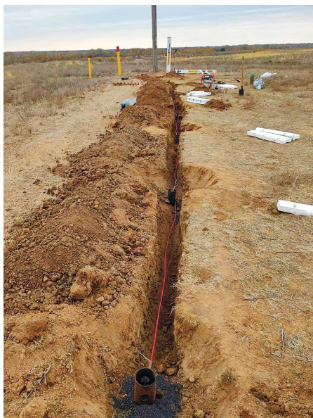
Рис. 3. Монтаж вертикальных анодных заземлений
