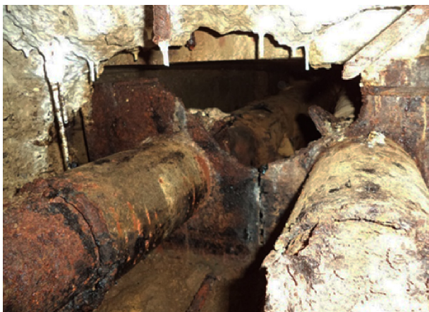
Рис. 7. Дефекты наружной коррозии на тепловых сетях [6]
