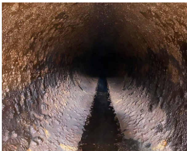
Рис. 8. Внутренняя коррозия на тепловых сетях [6]
