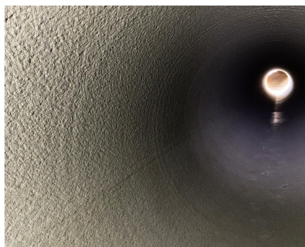
Рис. 6. Инновационный комплексный подход (ИКП) для восстановления и защиты трубопроводов тепловых сетей
