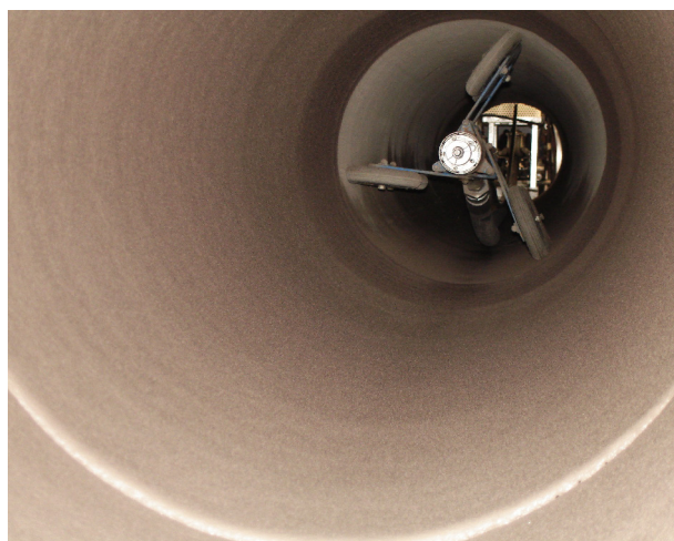
Нанесение покрытия на внутреннюю поверхность трубы
