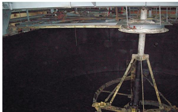
**Рис. 12. Контактный чан вместимостью 400 м<sup>3</sup>, футерованный химстойким композитом, в сернокислотном цехе АО "СУМЗ" г. Ревда**
