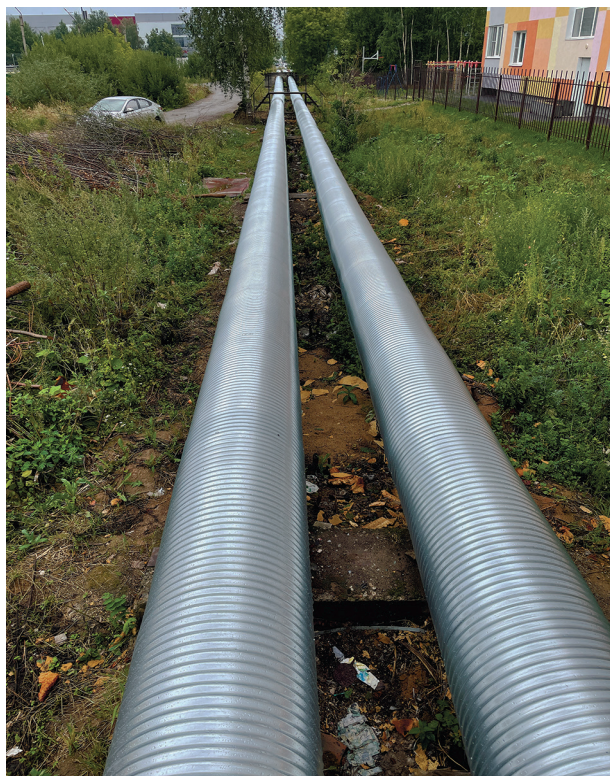
Рис. 2. Трубопровод в жесткой герметичной оболочке
